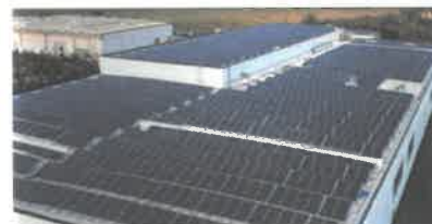
Immagine 15 - Impianto fotovoltaico installato nello stabilimento Neri Industria Alimentare a Lamporecchio (PT).
