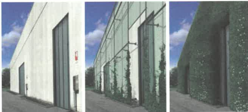
Immagine 33 - Successive fasi di schermatura di edifici con piante rampicanti. Sistema Greenover.
