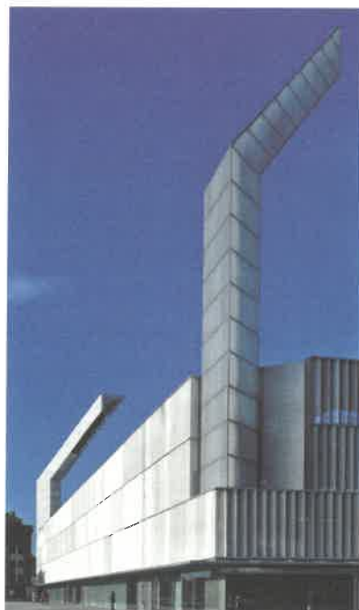
Immagine 21 - Facciata dello stadio Nueva Balastera a Palencia (Spagna)
