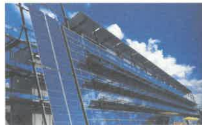
Immagine 14 - Solarfabrik, Friburgo: prospetto rivolto a sud, con inserimento di moduli fotovoltaici.
