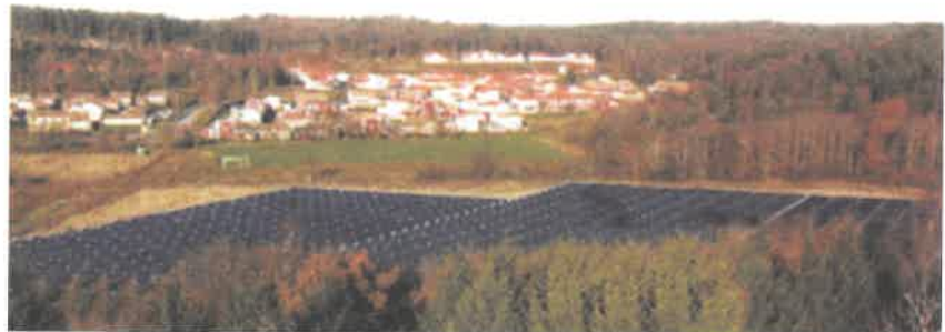
Immagine 12 - Impianto solare di tipo distrettuale in Danimarca.
